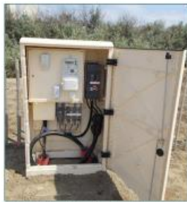
Coffret électrique (poste de livraison)
